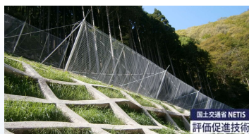
エネルギー吸収型小規模落石防護柵 ARCフェンス ・NETIS登録番号：:CB-020004-VE★
