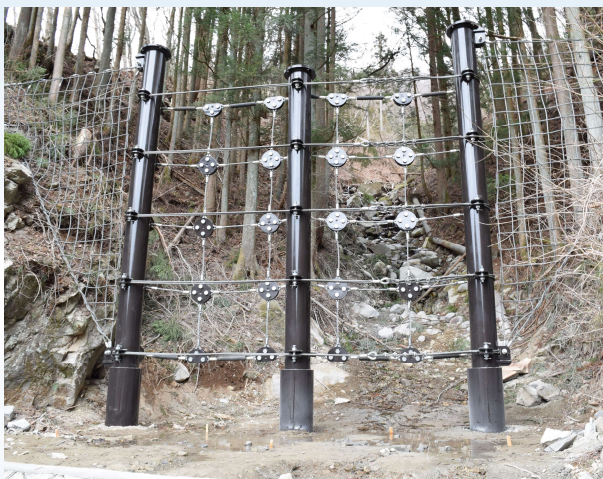
無流水溪流向け杭基礎 土石流・流木対策工 アーバンガード® （模型展示） ・建設技術審査証明：第2001号 ・NETIS登録番号：KT-210079-A
