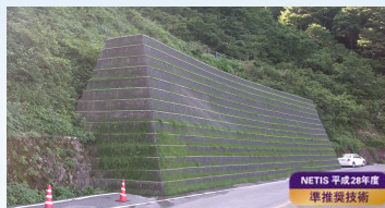
落石防護補強土壁（模型展示） ジオロックウォール® ・NETIS登録番号：HR-990009-V★
