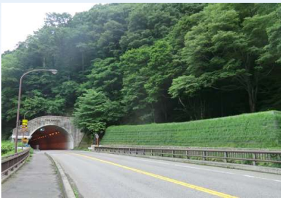
落石防護補強土壁
