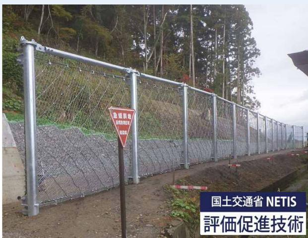
崩壊土砂防護柵
