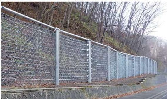
高エネルギー吸収型鉛直式落石防護柵
