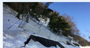
雪崩予防・落石防護兼用柵 SPARCフェンス® NETIS登録番号：HR-130008-A★
