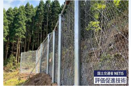
崩壊土砂防護柵
