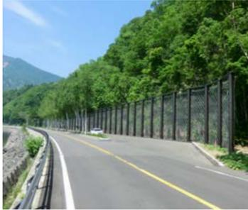
狭い場所への施工も可能にした崩壊土砂対策用製品「スロープガードフェンス」(北海道支笏湖)。
