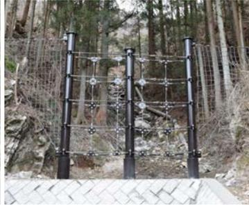
近年、ニーズが急増している小規模溪流向け土石流・流木対策製品「アーバンガード」(栃木県日光市)。
