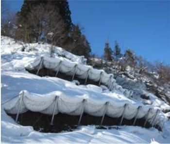
道路沿いに設置された雪崩・落石対策用製品「三角フェンス」(新潟県十日町)。周りの景観に溶け込んでいる。
