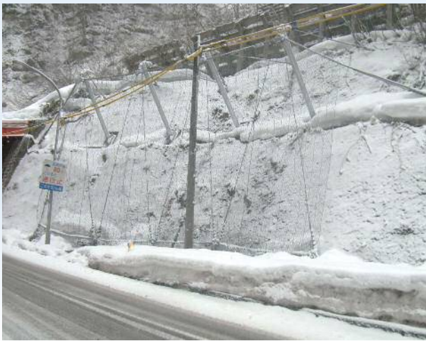
崩落雪防護網 スロープガードネット S タイプ（模型展示）
