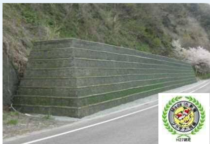
落石防護補強土壁
