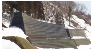
雪崩防護補強土壁 ジオスノーウォール NETIS登録番号：HR-990009-V
