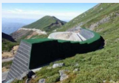
落石防護補強土壁
