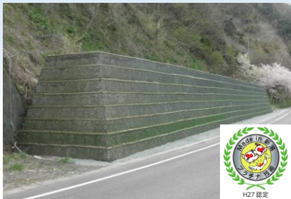
落石防護補強土壁 ジオロックウォール （模型展示） ・ Made in 新潟登録番号：18D1040 ・ NETIS登録番号：HR-990009-V （NETIS 平成28年度 準推奨技術）
