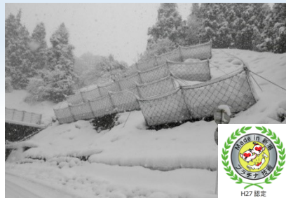
エネルギー吸収型小規模落石防護柵 ARCフェンス Sタイプ （模型展示） ・ Made in 新潟登録番号：18D1037
