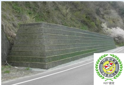
落石防護補強土壁 ジオロックウォール （模型展示） ・ Made in 新潟登録番号：18D1040 ・ NETIS登録番号：HR-990009-V （NETIS 平成28年度 準推奨技術）
