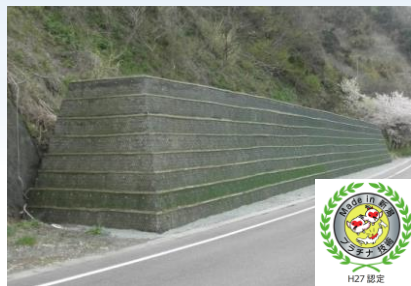
落石防護補強土壁（模型展示） ジオロックウォール
