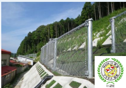
崩壊土砂防護柵（模型展示） スロープガードフェンス タイプLE
