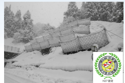
エネルギー吸収型小規模落石防護柵 ARCフェンスSタイプ
