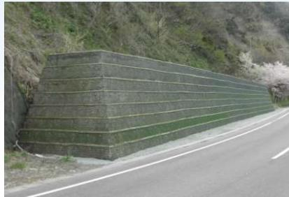
落石防護補強土壁
