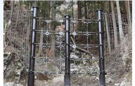
小規模渓流向け杭式土石流・流木対策工
