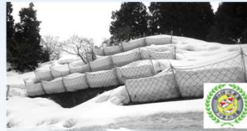
雪崩予防・落石防護兼用柵 ARCフェンスタイプ
