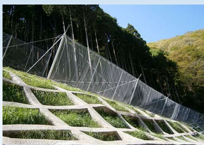
エネルギー吸収型小規模落石防護柵 ARC(アーク)フェンス NETIS登録番号: CB-020004-VE★ (NETIS 平成29年度 評価促進技術) Made in 新潟登録番号: 18D1037
