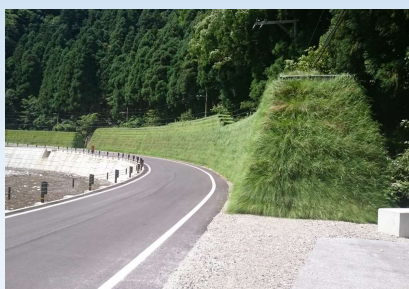
落石防護補強土壁 ジオロックウォール® (模型展示) NETIS登録番号: HR-990009-V★ (NETIS 平成28年度 準推奨技術) Made in 新潟登録番号: 18D1040 新潟県知事表彰「技術賞」受賞
