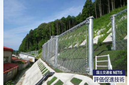
崩壊土砂防護柵
