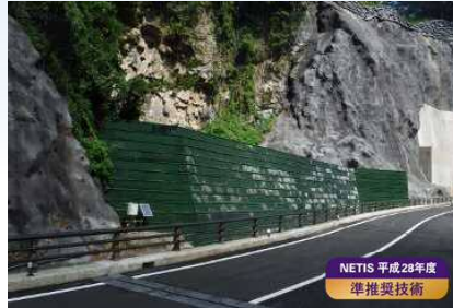
落石防護補強土壁
