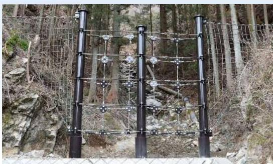
小規模溪流向け杭式土石流・流木対策工
