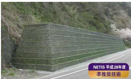
落石防護補強土壁（模型展示）
