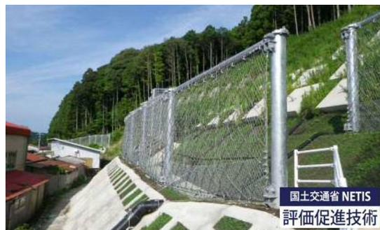
崩壊土砂防護柵（模型展示）
