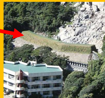
守られた小学校 学校裏にそびえ立つ絶壁。 落石から小学校を守る落石対策製品。
