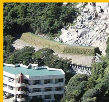
守られた小学校 学校裏にそびえ立つ絶壁。 落石から小学校を守る落石対策製品。
